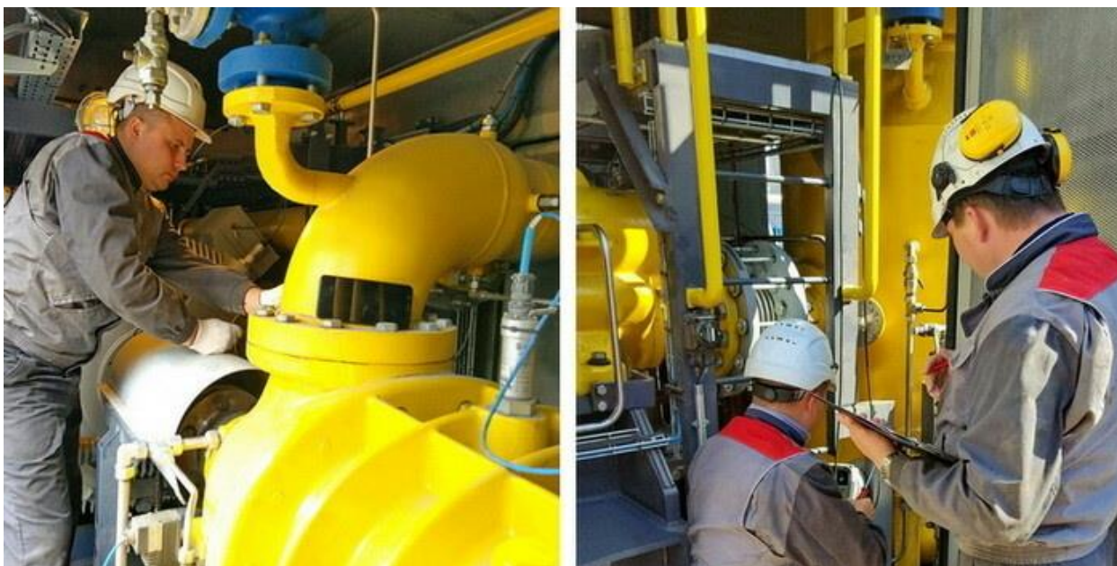
Рисунок 2 - Плановое техобслуживание оборудования газоподготовки на ГТУ-ТЭЦ «Восточная»
