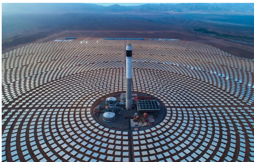
Рис. 1 Солнечная электростанция (СЭС)
