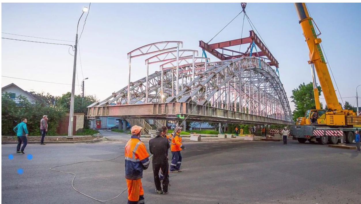
Рисунок 3 – Установка надземного пешеходного перехода в Нижегородской области.
