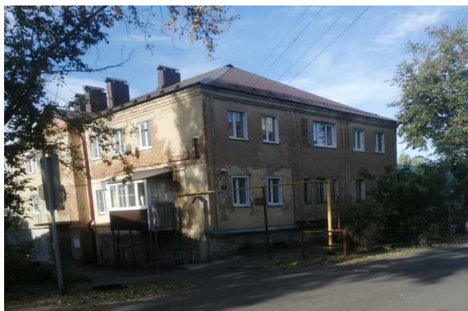
Рисунок 5 – Современное здание на старом фундаменте
