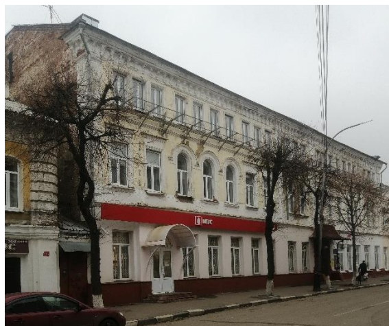
Рисунок 11 – Современный вид здания. В настоящее время здесь располагается музыкальная школа №1
