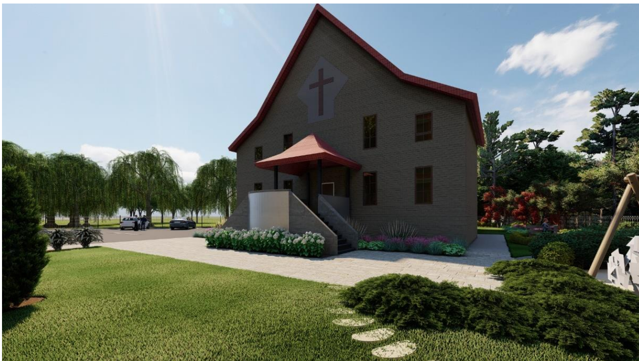
Рисунок 2 - Вид на здание Церкви "Примирение"
