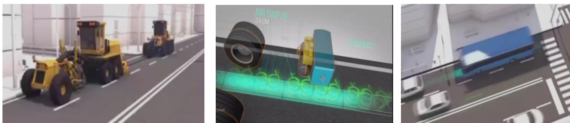
а – подготовка траншеи для установки катушек; б – зарядка электротранспорта; в – движение автобуса по маршруту
