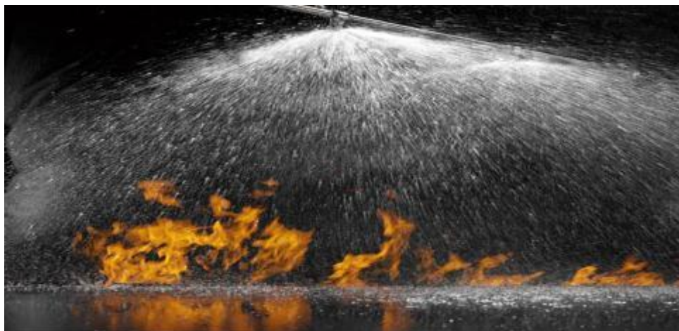
Рисунок 2 - Момент срабатывания спринклера
