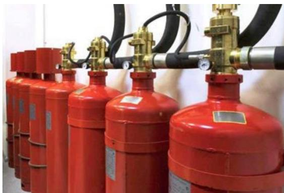
Рисунок 1.3 – Установка газового пожаротушения
