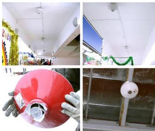
Рисунок 1.5 – Аэрозольные установки пожаротушения
