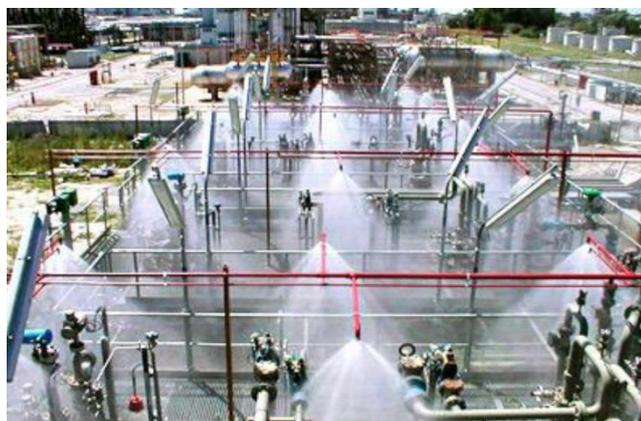
Рисунок 1.6 – Автоматическая установка водяного пожаротушения
