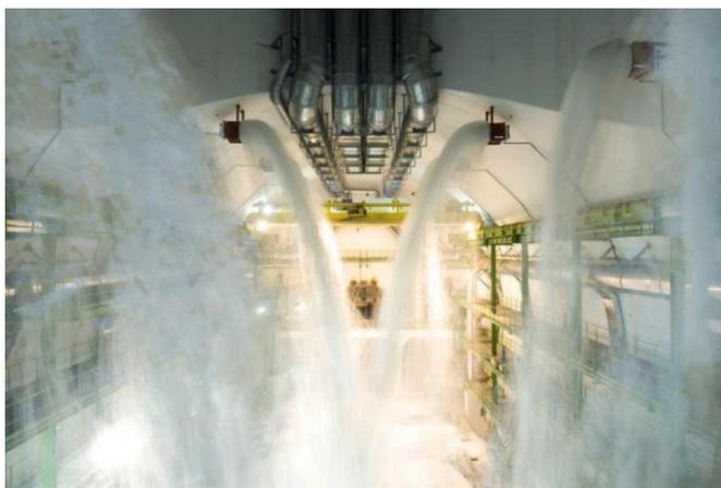
Рисунок 1.4 – Пенная установка пенного пожаротушения
